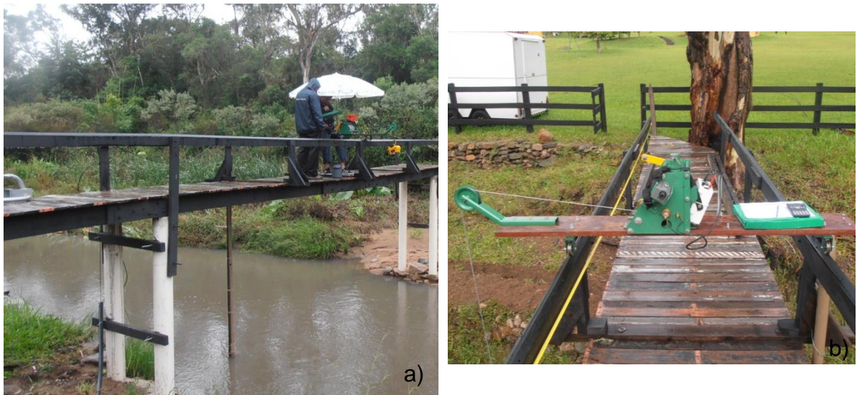
Figura 4 – Estrutura construída para realizar as medições de vazão, concentração de sedimentos em suspensão e sedimento transportado em arraste (a) e detalhe da instalação do guincho hidrométrico (b) na bacia hidrográfica do Arroio do Ouro.
