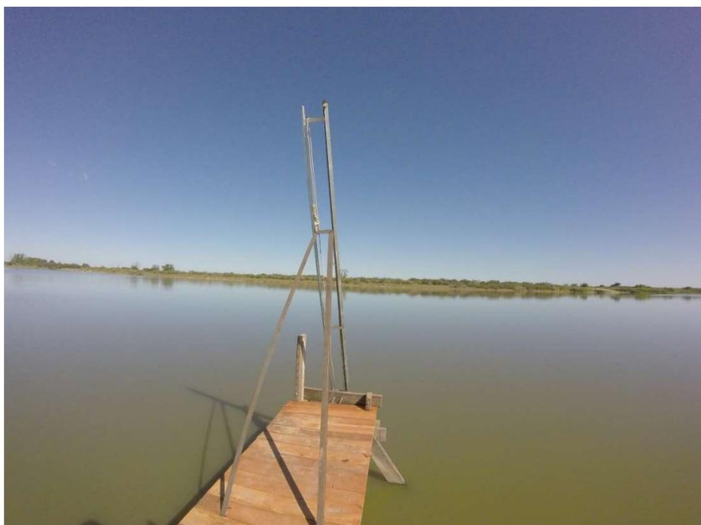
Figura 18 - Estrutura metálica instalada para fixação do SL500.
